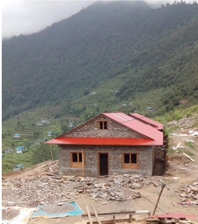
Kindergarten in Hewa, Innenausbau läuft
